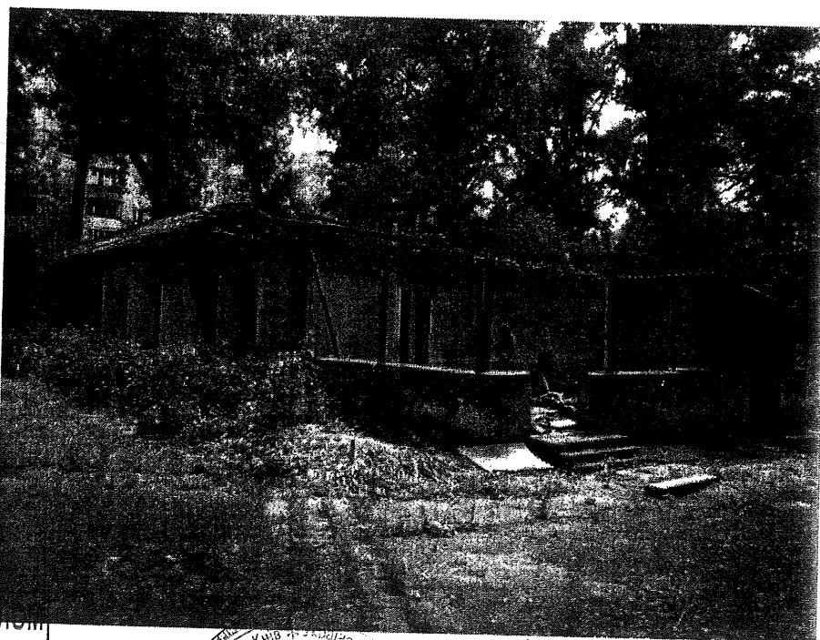
Фото 2. Вигляд будівлі по осі А в осях 1/1-3 та по осях 2 та 3
